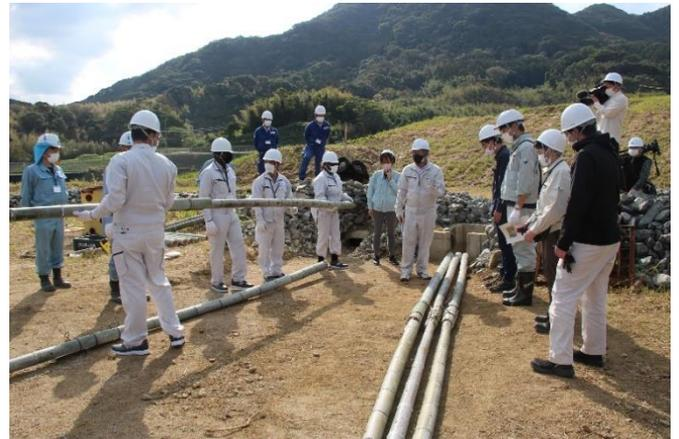
簡易集排水管等の作成と設置実習（福岡市中田埋立場）
